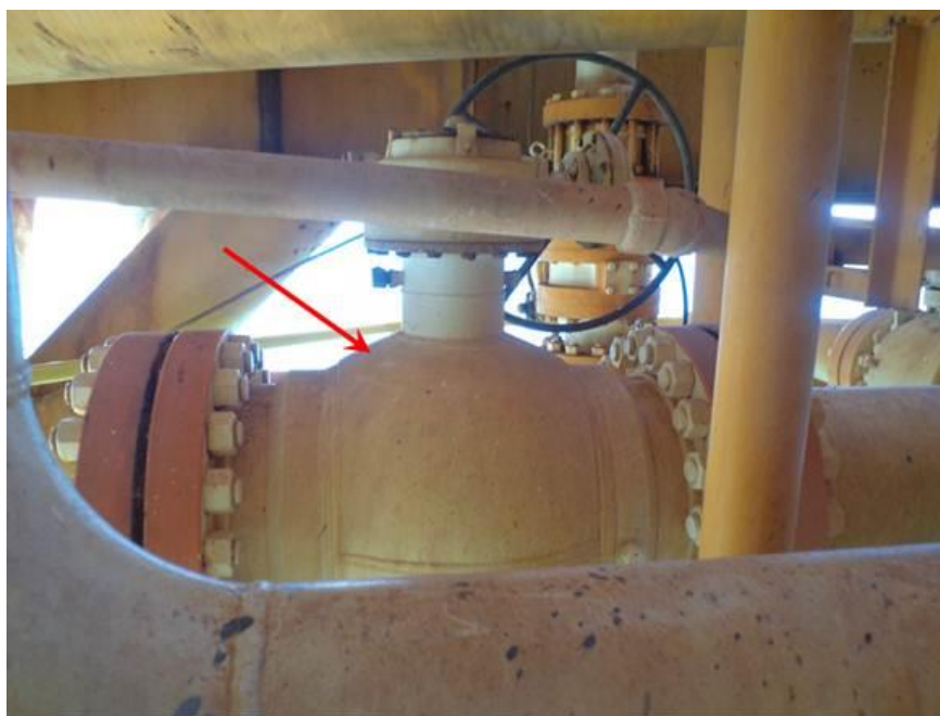
Fig. 2 Válvula disponible de 14" en el cabezal general de producción para interconexión de línea de proceso a trampa de diablos.
